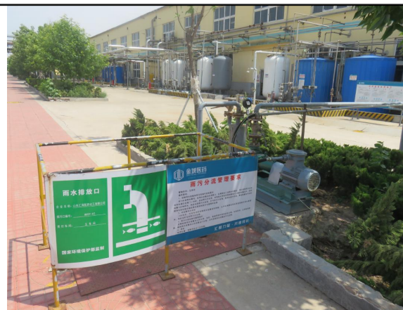
厂区雨水排放口
