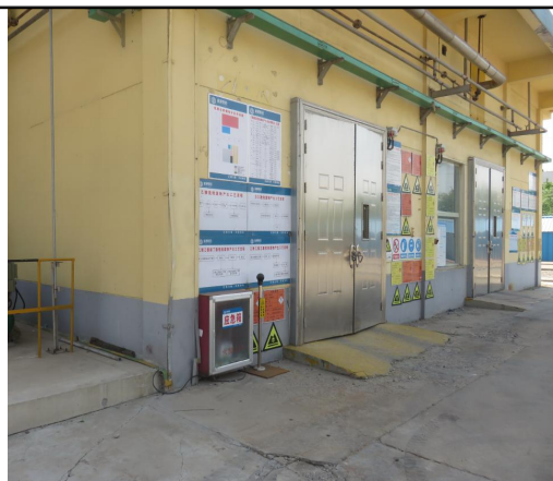
危险废物暂存间
